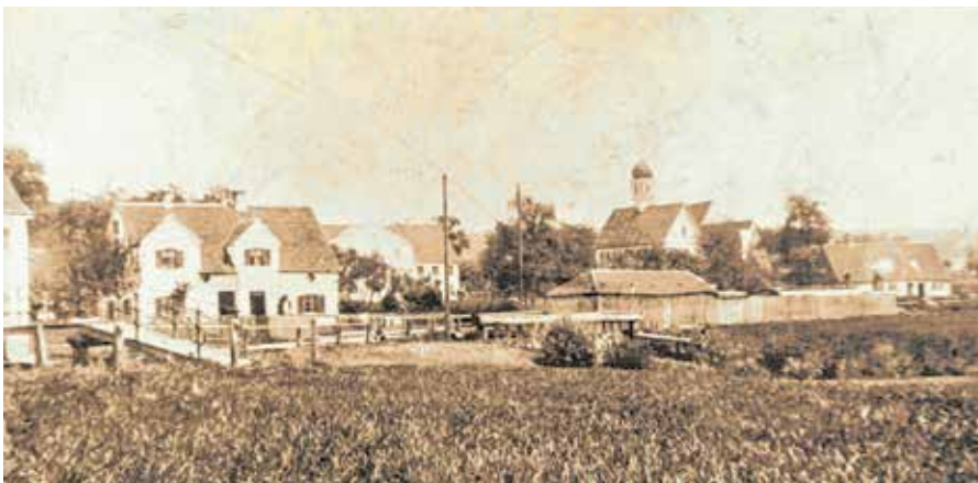
An der Brunnenstraße in Hürben befanden sich das einstige Wannenbad (links im Bild) und das Kammel-Flussbad.
