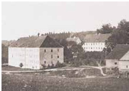
Das Krumbad um 1891: Dominikus Ringeisen kaufte die Gebäude in sanierungsbedürftigem Zustand.
