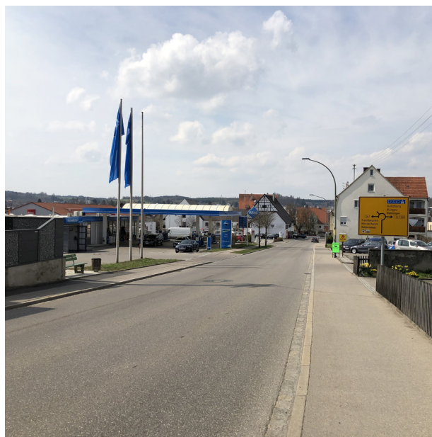
Abbildung 19: Fehlende Radverkehrsanlagen auf der Augsburgsburger Straße (B 300)
