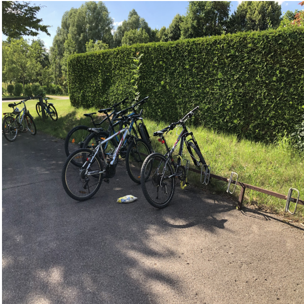
Abbildung 25: Fahrradabstellanlagen „Felgenbrecher“ am Freibad
